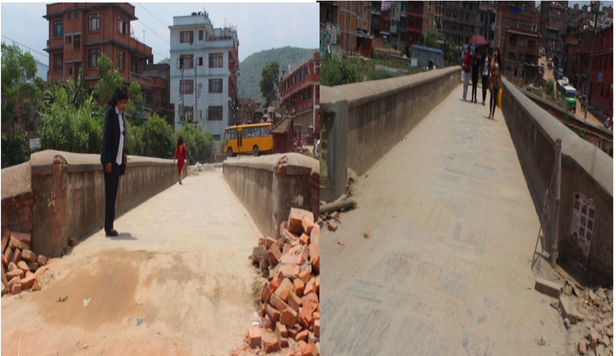
वडा नं १६, बंशगोपाल बाराहीस्थान पुल तथा सडक मर्मत कार्य (सडक बोर्ड नेपालका आयोजना)
