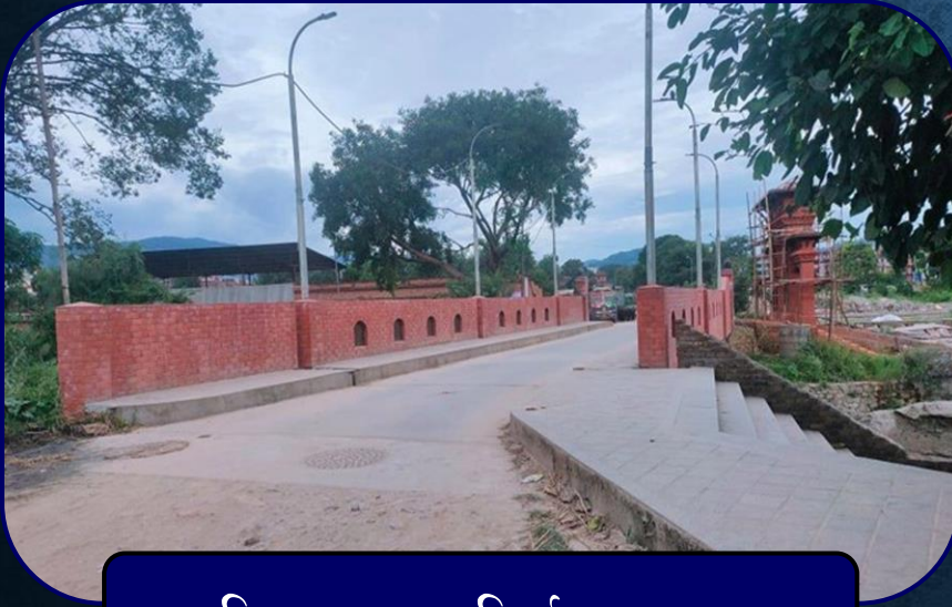
छिपा ताा पुनःनिर्माण सम्पन्न
