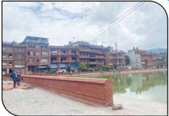
भक्तपुर नपाबाट नःपुखूको पर्खाल पुनर्निर्माण
