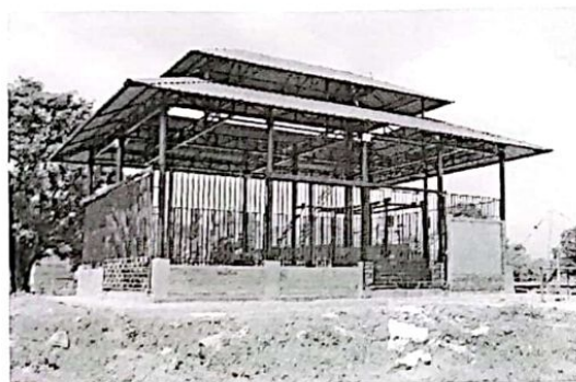
सधुरिएको शवदाहगृह निर्माण
